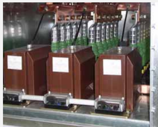
Стандартные трансформаторы напряжения фронтальной установки, согласно DIN 42600 часть 9
