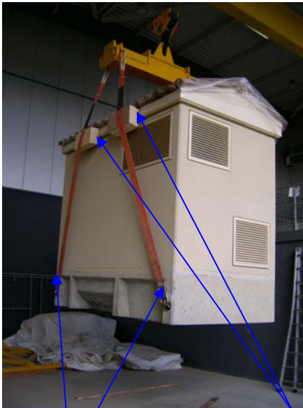
Plaques de polystyrène pour écarter les élingues des tuiles basses
